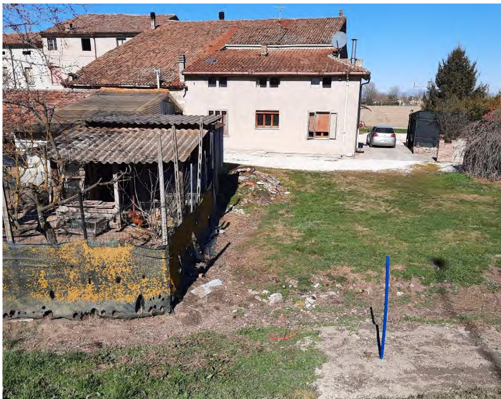
Figura 13 - Tracciamento della rete acquedottistica interrata in seguito a sopralluogo. Il picchetto blu nella foto evidenzia la posizione della tubazione.
