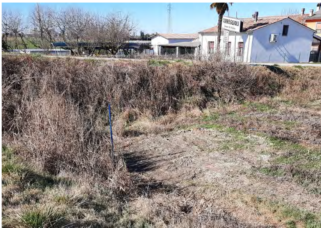
Figura 12 - Tracciamento della rete acquedottistica interrata in seguito a sopralluogo. Il picchetto blu nella foto evidenzia la posizione della tubazione interrata.
