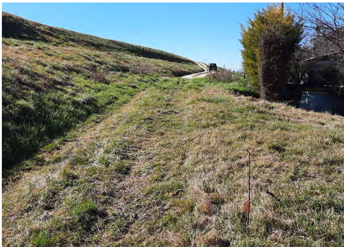
Figura 10 - Tracciamento della linea telefonica interrata in seguito a sopralluogo. Il picchetto nella foto evidenzia la posizione della linea interrata.
